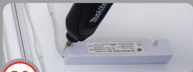
AC100V ラインコンセント用スリムアダプタをビス止め
