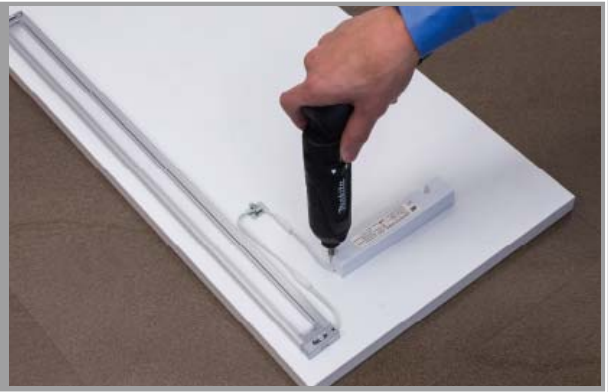
AC100V ラインコンセント用スリムアダプタをビス止め
