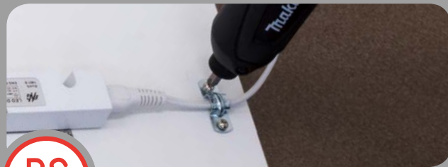
AC100V ラインコンセント用コードを棚にビス止める
