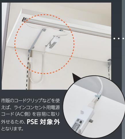
市販のコードクリップなどを使用すれば、ラインコンセント用電源コード(AC側)を容易に取り外せるため、**PSE対象外**となります。
