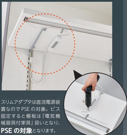
スリムアダプタは直流電源装置などでPSEの対象。ビス固定すると棚板は「電気機械器具付家具」扱いとなり、**PSEの対象**となります。
